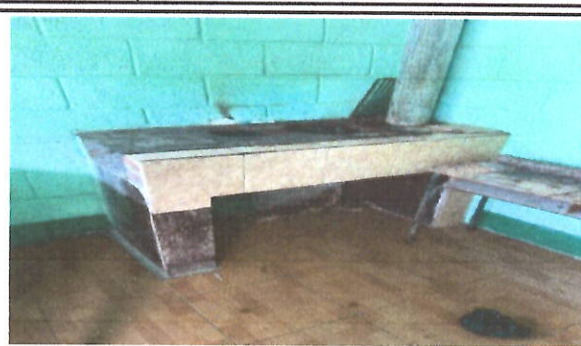
FOTO2: REPARACIÓN O SUSTITUCIÓN DE ÁREA DE COCINA sustitución de estufa rural con chimenea, plancha y accesorios.
