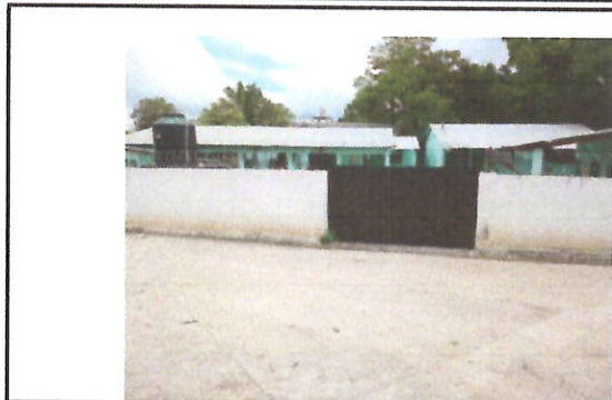
FOTO1: PINTURA EN MUROS INTERIOR Y EXTERIOR Preparación de la superficie y aplicación de pintura a dos manos, en paredes interiores y exteriores del establecimiento en muro perimetral
